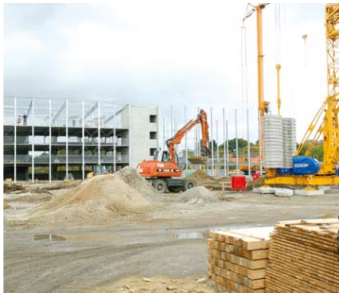
Hier entsteht ein Bürogebäude mit modernen Arbeitsplätzen
