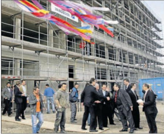
Polier Klaus Schneider (oben auf dem Gerüst) übernahm den Richtspruch für die neue Firmenzentrale von Hönigsberg & Düvel. Foto: Lohmann
